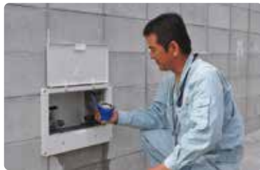
水量不審宅での 漏水調査の様子
