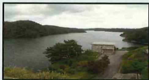
福地ダムの様子(参考: R1.6.21 100%記録時) 写真: 北部ダム統管理事務所提供
