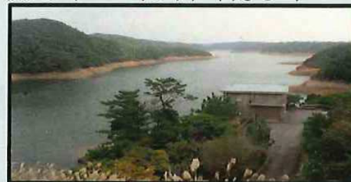
福地ダムの様子(12/31 14時) 写真: 北部ダム統管理事務所提供
