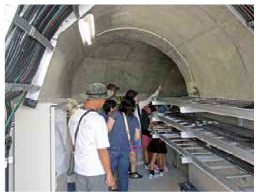
金武ダム 地下室はひんやりして気持ちよかったよー
