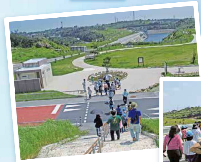
金武ダム ダムの堤防を歩きました
