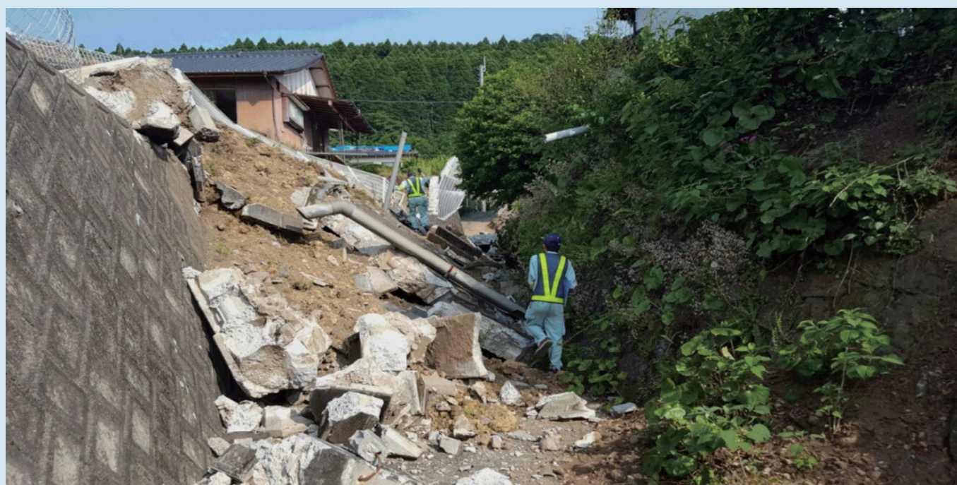
布田地区：布田川活断層真上の集落。ほぼ全壊状態でふさがれた道を進みながら漏水調査を続けました。
