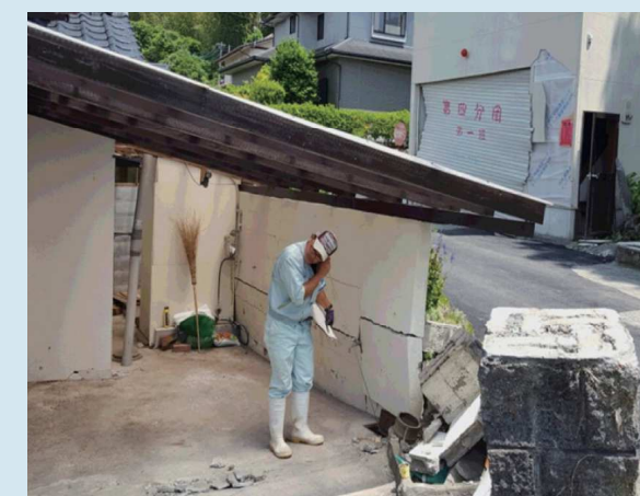
誰もいない住宅地域を一件ずつ漏水調査を実施した。
