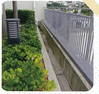
建物の降り注いだ雨は、このような溝から、建物の内部にあるパイプに流れていきます。
