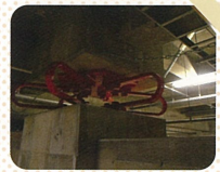
U字型鋼材ダンパー。鉛と同じように延性と、バネのような形で地震の揺れをおさえます。
