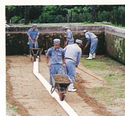
汚過池の砂かきとり
